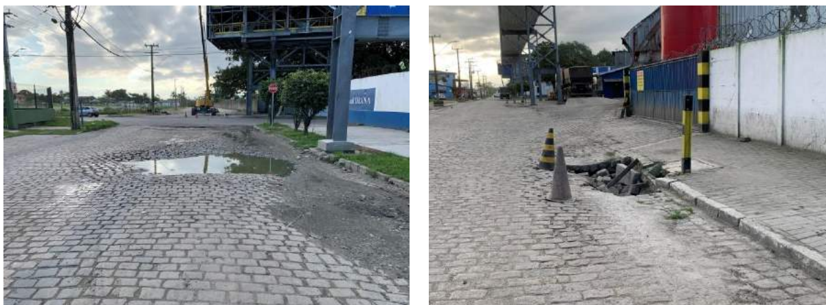
Figura 65: Más condições observadas na Avenida Gabriel de Lara, julho de 2020.
