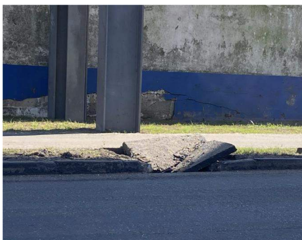
Figura 43: Comprometimento parcial das estruturas de drenagem na Av. Bento Rocha e Av. Gabriel de Lara.
