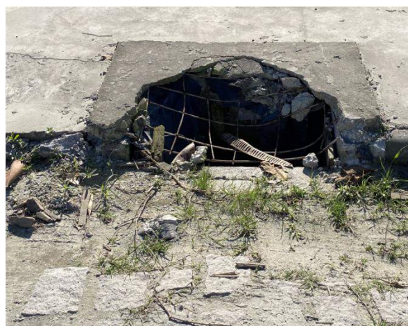
Figura 43: Comprometimento parcial das estruturas de drenagem na Av. Bento Rocha e Av. Gabriel de Lara.
