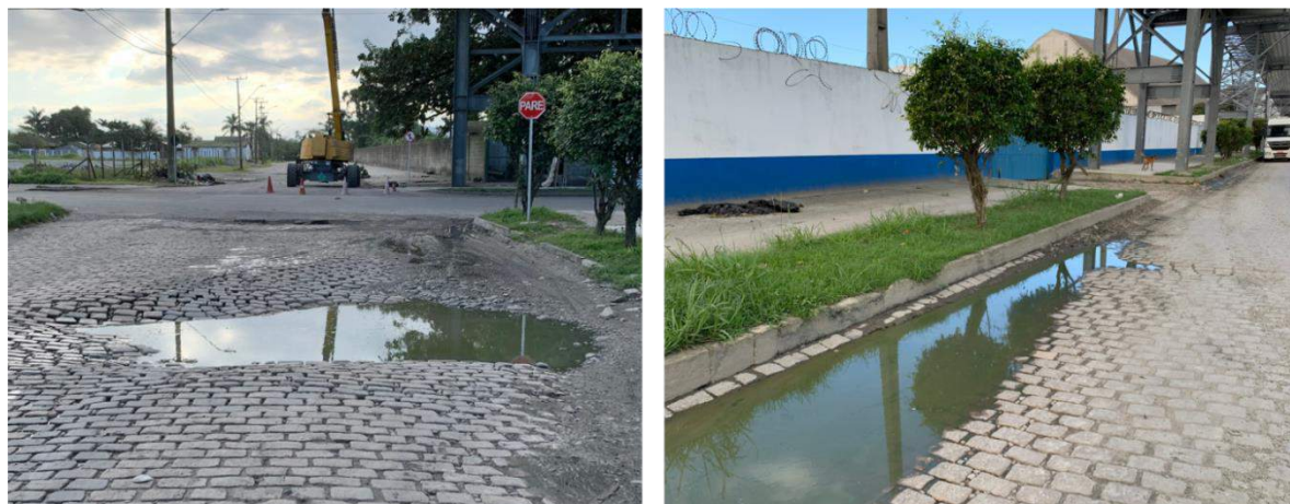
Figura 44: Pavimentação parcialmente comprometida na Avenida Gabriel de Lara.
