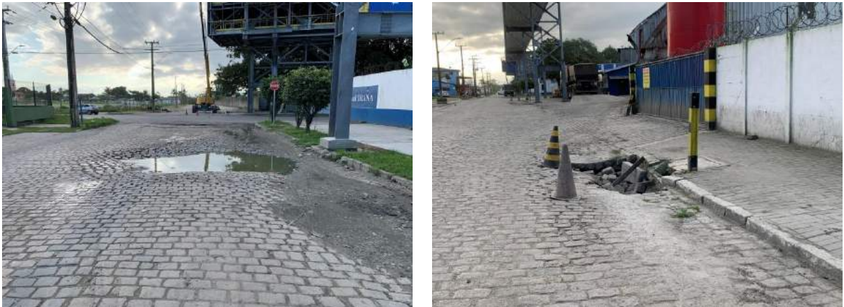
Figura 11: Más condições observadas na Avenida Gabriel de Lara, julho de 2020.
